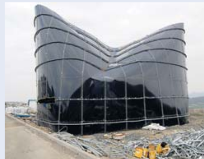
Emaillierter Stahl: Mittelteil eines zerbeulten Fermenters.
